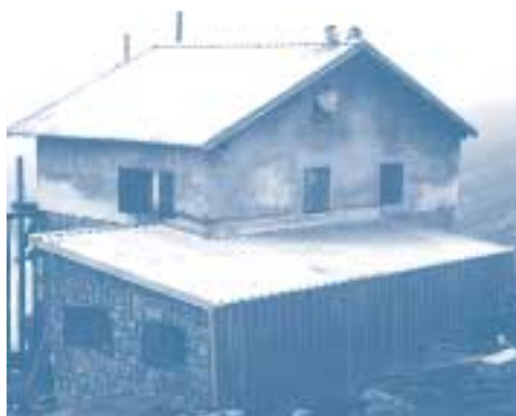
Sopra: i lavori di ampliamento nella fase avanzata (Archivio SEM)
